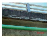
元触橋の点検(左写真より、点検の様子、橋梁端部での段差、地覆部の遊離石灰)
