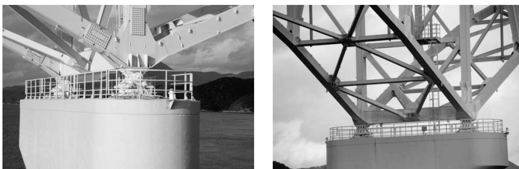
図 7.2-5 支承部の撮影画像の比較（左；UAV，右；地上）
