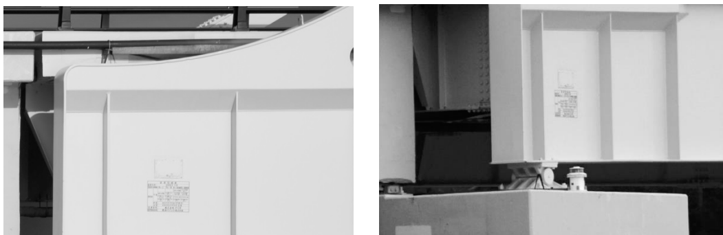
図 7.2-10 補剛桁の補修銘板画像の比較（左；UAV，右；地上）
