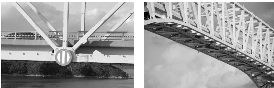
図 7.2-4 支間中央部の撮影画像の比較（左；UAV，右；地上）
