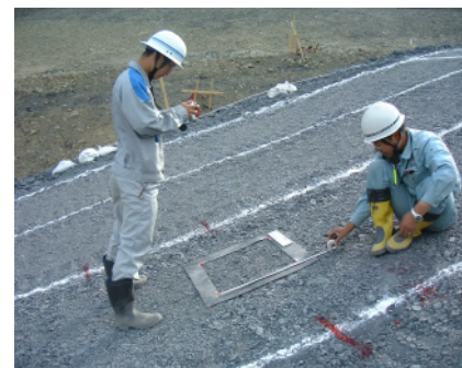
写真-3 トランジション表面撮影状況
