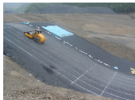
写真-2 トランジション盛立試験状況
