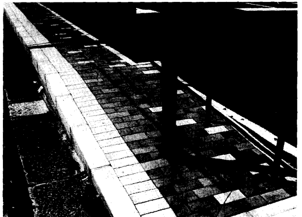
写真-6 市民病院前のスロープ
