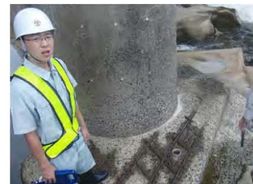
橋脚基礎部の鉄筋露出
