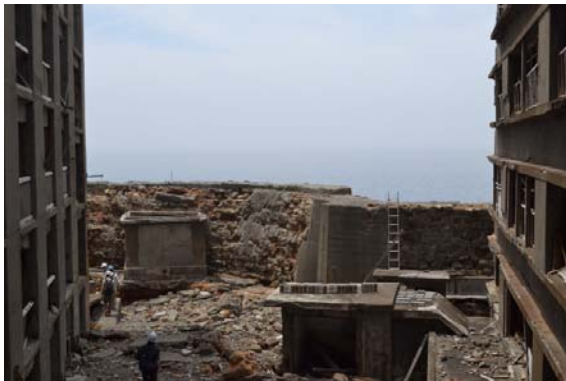
(a) 試験体設置位置
