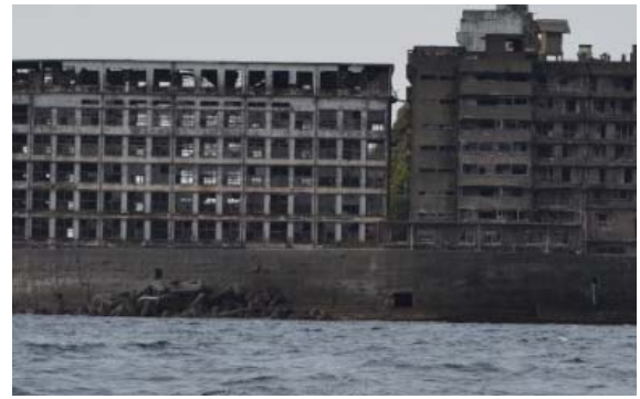
(a) 試験体設置位置
