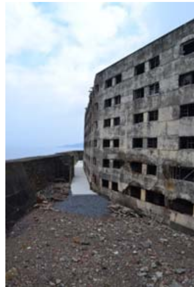
(a) 試験体設置位置
