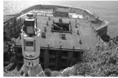
3D レーザ計測状況
