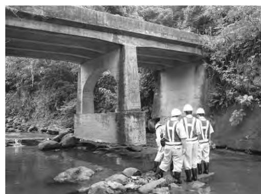
山住橋の点検 (橋脚基礎部の欠落)
