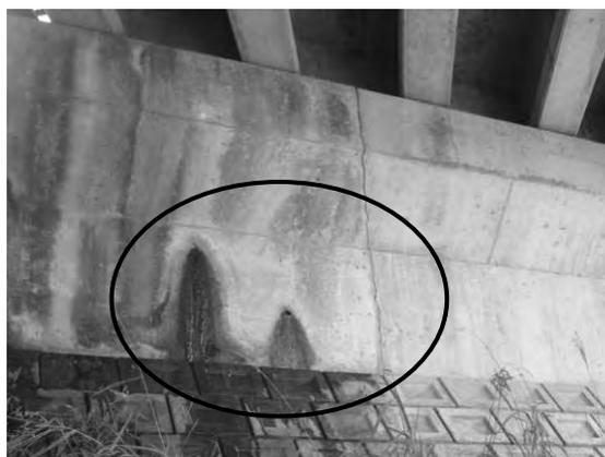
漏水、ひび割れ（橋台）
