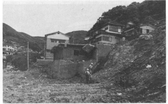
写真4 山崩れによって上部2階建木造住宅を失った 半地下の鉄筋コンクリート造倉庫(鳴滝)
