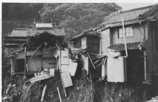
写真9 崖崩れによる木造被害（本河内町御手洗）
