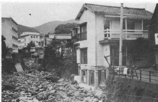
写真13 基礎を支えるコンクリート柱により倒壊を免れた例（片瀬一丁目）
