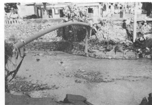
写真 6-8 芋原橋，左岸側，橋台付近破壊状況
