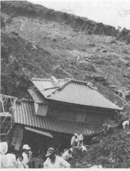
写真1 山崩れによる斜面下木造住宅の倒壊 (本河内奥山)
