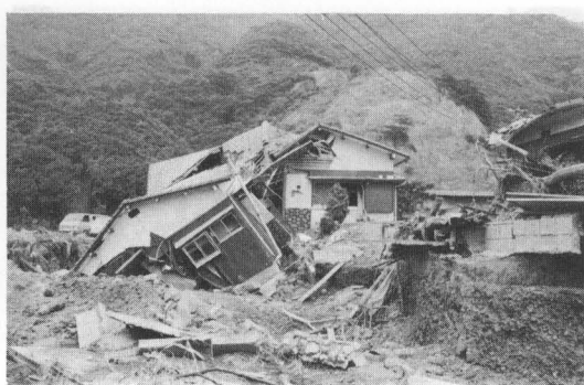
写真14 橋のダムアップにより地盤が流出して倒壊した例（東町長龍寺）
