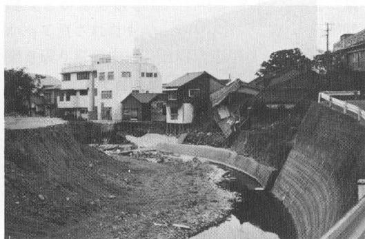
写真10 川の曲がり部分の水流による被害（下西山町）
