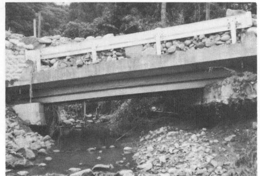
写真 6-16 田の頭橋，兩岸橋台下洗掘，橋台沈下，上部構造傾斜
