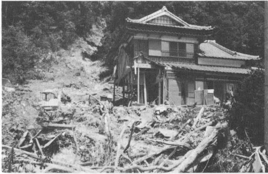
写真3 やや沢筋の斜面の山崩れによる損壊 (船石町)
