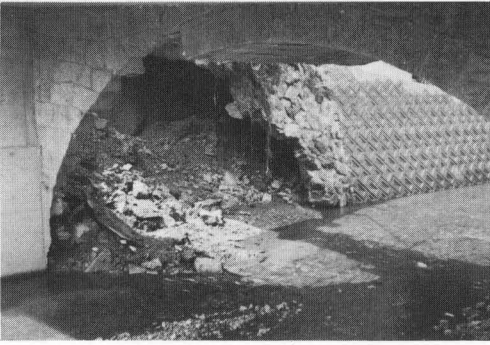
写真 6-9 千束野橋，左岸 橋台洗掘状況（上流側鉄筋コンクリート橋）
