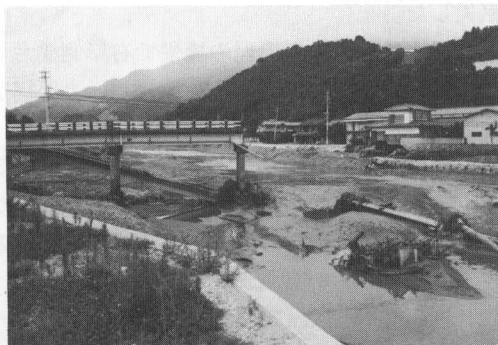
写真 6-19 蛸道橋，右岸側 2 径間残し，左岸側 4 径間橋脚・橋台共流失
