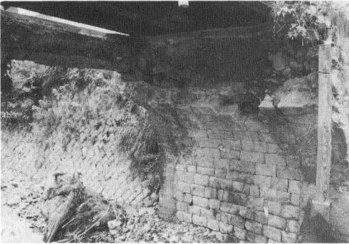
写真 6-10 現川橋，流失しなかった右岸側アーチ石
