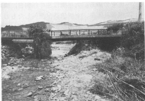
写真 6-17 大川橋，左岸石積護岸橋台流失，上部構造は仮支柱で支持されている
