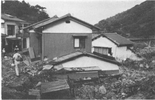
写真5 沢筋の土石流による被害(芒塚)
