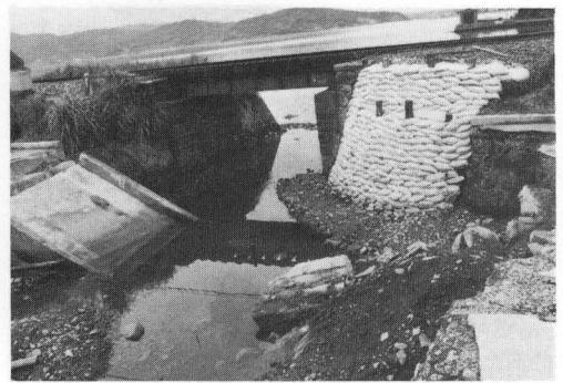
写真 6-15 浜田橋，右岸橋台流失，上部構造落橋破壊
