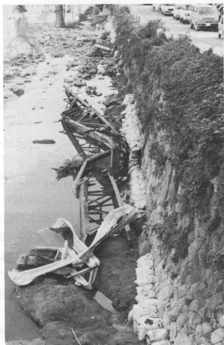
写真 6-18 昭和橋，流失した鋼 I 形桁
