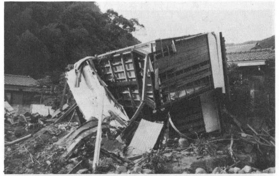
写真2 山崩れの土石流による鉄骨住宅の倒壊 (本河内奥山)
