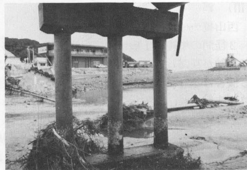
写真 6-20 蛸道橋，残った橋脚，コンクリートパイルの簡易橋脚構造
