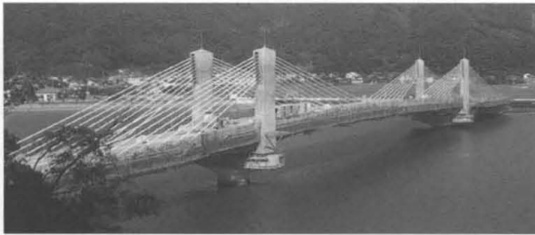
図-1 建設中の佐敷大橋（熊本県）
