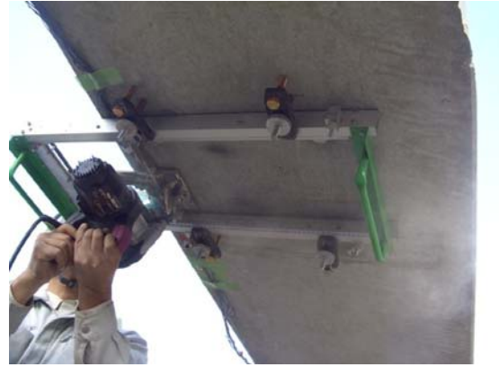
写真-5.4.3 スリット切削状況
