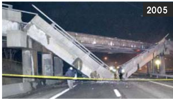
1-70コンクリート跨道橋の崩壊 (米:ペンシルバニア州) [3]
