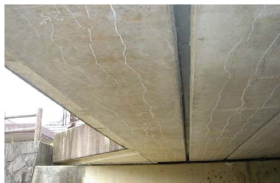
写真－7.1.2 PC桁下面に生じた軸方向のひび割れ
