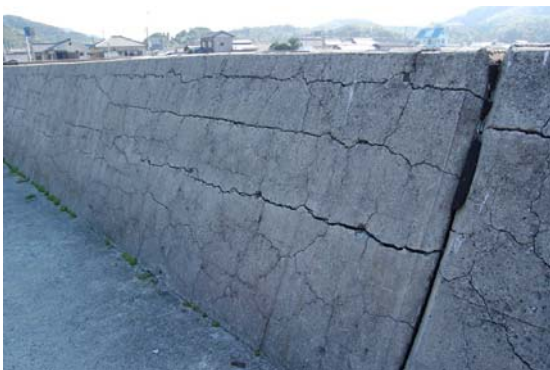
写真－7.1.1 防波堤に生じた亀甲状のひび割れ
