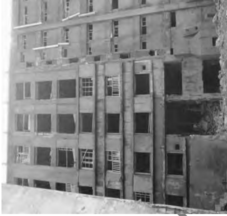
写真-3.1.5 30号棟現状 5
