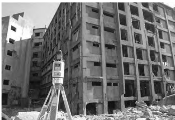
写真-3.4.2 30号棟計測状況
