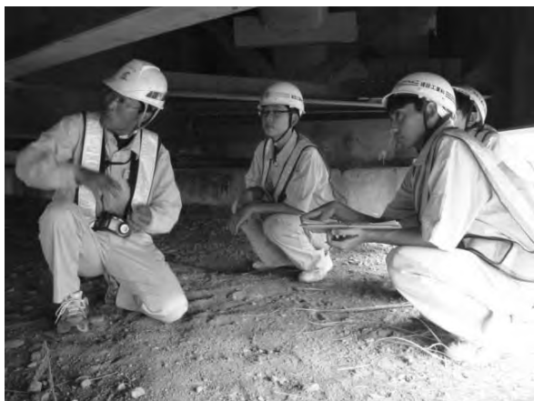
調査・点検実習状況（久良原橋）
