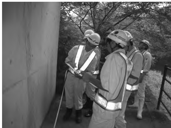
調査・点検実習状況（田ノ平橋）
