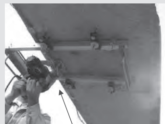
スリット削孔
