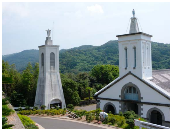
写真3-4 カトリック出津教会の鐘楼と聖堂
