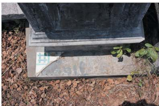
15-2 1号墓西端床面のタイルと剥離状況（6インチ井桁文マジョリカ）
