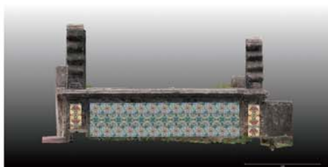
12-4 タイル復元全景（北面）
