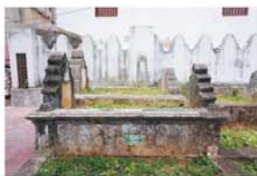
8-5 タイル残存状況（北面）
