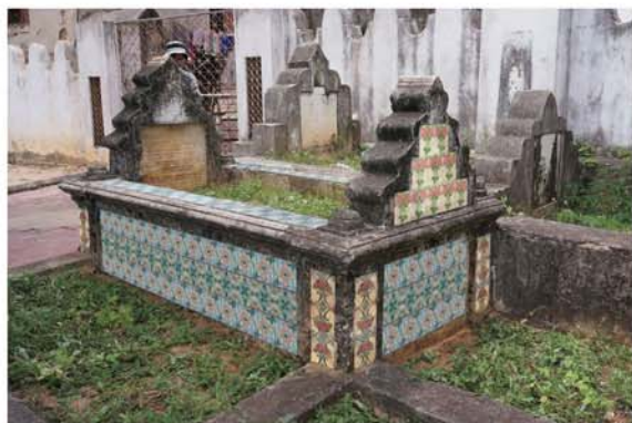
12-2 タイル復元全景（北西から）
