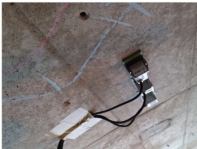
補強対策工施工前
