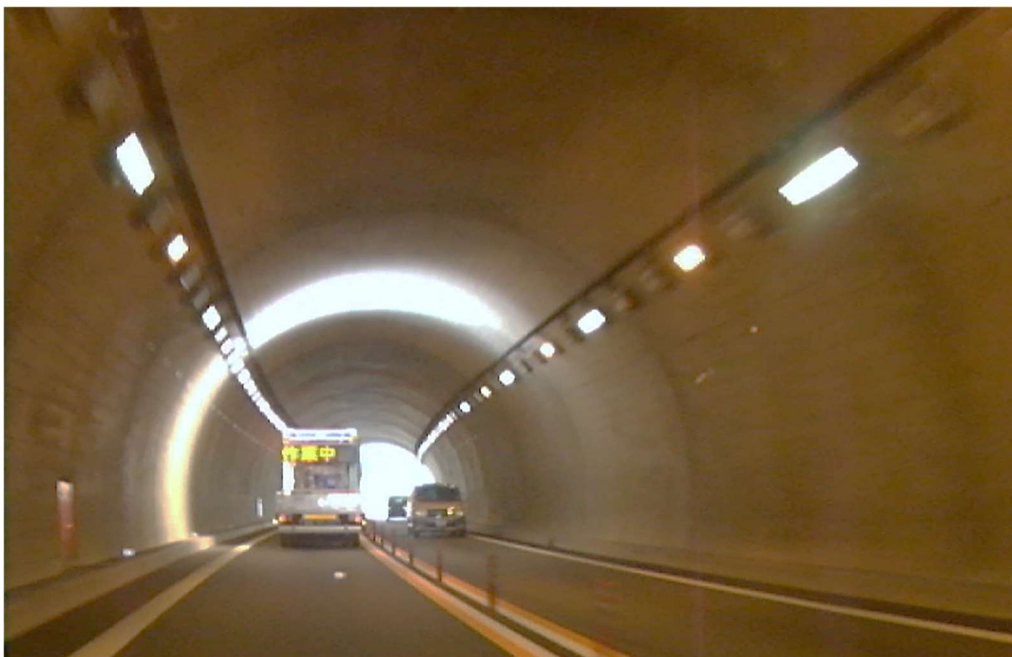
写真 4.2-1 可視光照明を使用した覆工表面撮影状況の例
