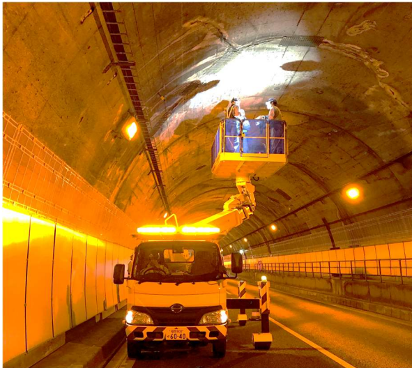
写真 2.3-1 近接目視，打音検査状況
