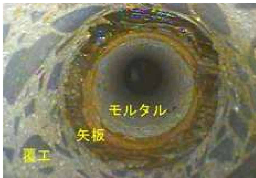
写真 7.4-1 削孔空洞調査孔内状況の例
