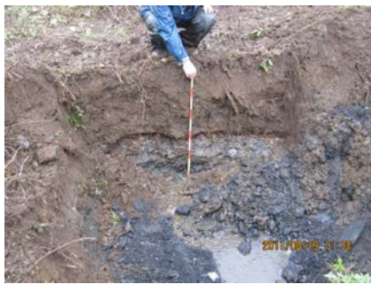
関東 B2 現場 (管理型処分場)
