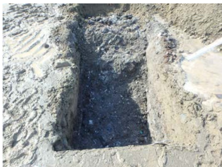
関東 B1 現場 (管理型処分場)
