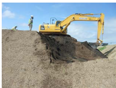
東北 E 現場 (震災廃棄物仮置場)
