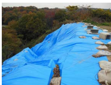
図 3-3(2) 同左・破損した U 字溝を起点とした崩壊
