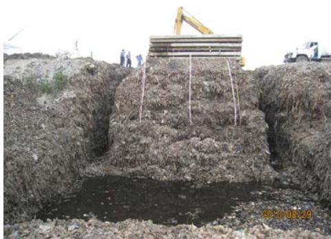
図 3-7 断面整形後， 載荷時 斜面高 9m， 勾配 63.5°， 載荷重 8.6 kN/m 3
