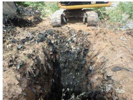
スリランカ現場
