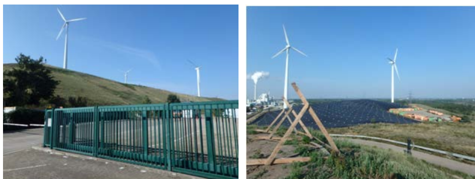
図 4-1 ドイツ・カールスルーエ エネルギーの丘 (Karlsruhe-West)
