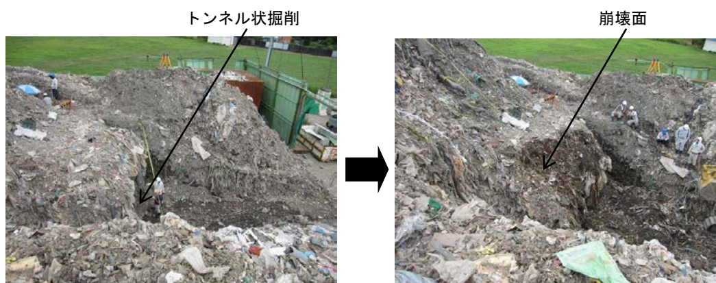
図 3-12 国内不法投棄等現場（中部 C1）での崩壊実験 （左写真：矩形トンネル状の掘削 右写真：崩壊後）
