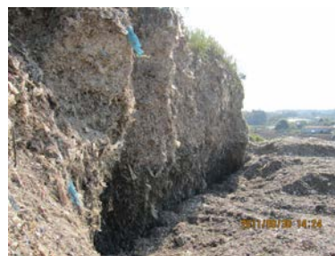
図 3-3(3) 厚さ 1m の表面くずれが生じた直壁（関東 C1 現場）
