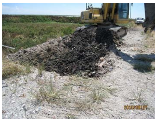
図 3-5 実験断面成型のための掘削
