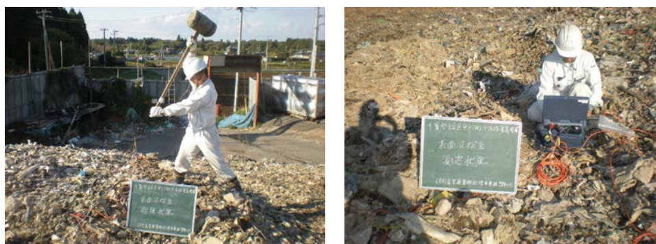
図 4-16 表面波探査・測定状況
