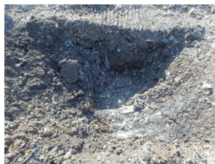
中部 B 現場 (管理型処分場)
