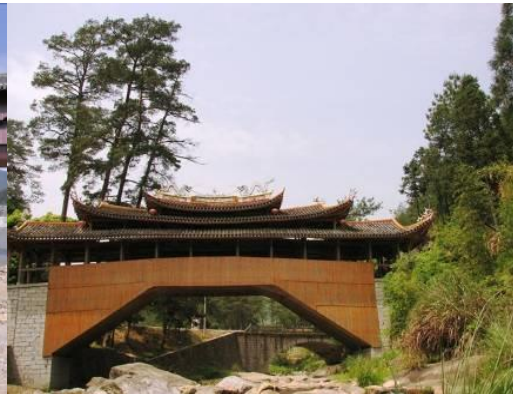
(d) Tongle Bridge
