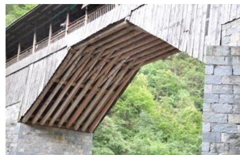
(d) Up view of the arch
