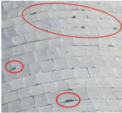
写真-32 型枠から漏れ出たモルタル分(O印)
