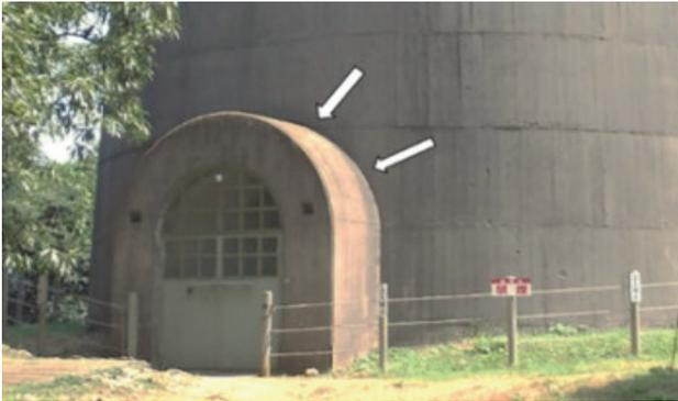
写真-24 塔入口(型枠厚さ跡 矢印)
