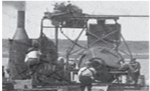
写真-18 利根川萬生水門工事(1916年)のキューブ型ミキサー (土木学会土木貴重写真コレクションより)
