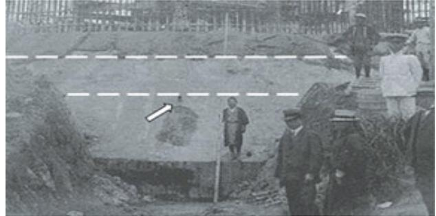
写真-10 基礎コンクリート(水抜穴の矢印とリフト割の点線)
