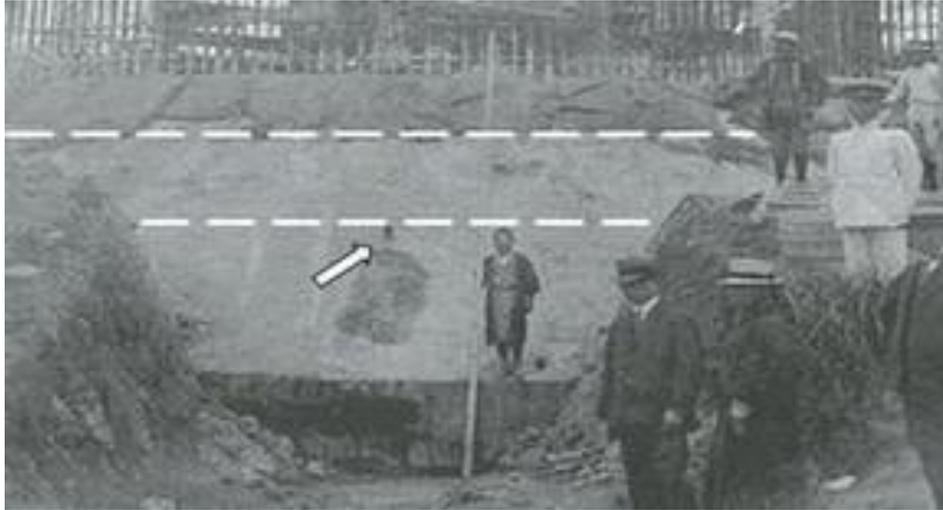
写真 4.3-7 基礎コンクリート(水抜穴の矢印とリフト割の点線)
