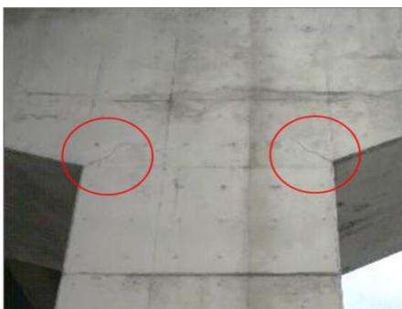
写真 5.2-7 T型橋脚の断面変化部に発生した沈下ひび割れ現象
