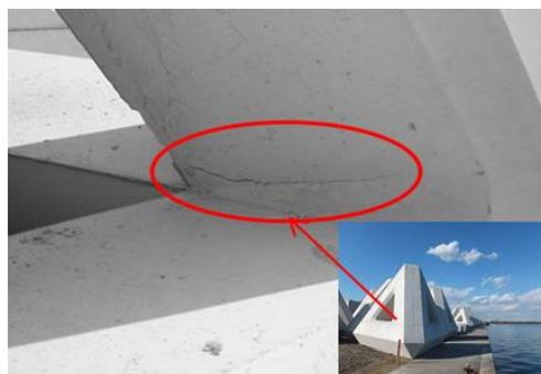
写真 5.2-8 中空三角ブロック(80t)に発生した沈下ひび割れ現象
