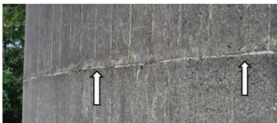
写真 5.2-1 無線塔の打継目のレイタンス(矢印)
