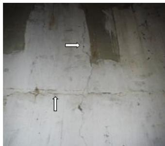
写真 5.2-3 完成当時発生していたと考えられる乾燥収縮ひび割れ(右向き矢印)と沈下ひび割れ(上向き矢印)
