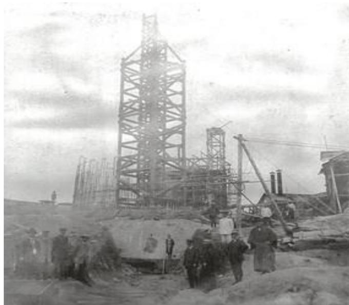
写真 4.3-1(古写真3) 基礎コンクリート完成写真
