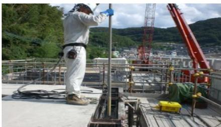
写真 5.2-5 長尺高周波バイブレーター
