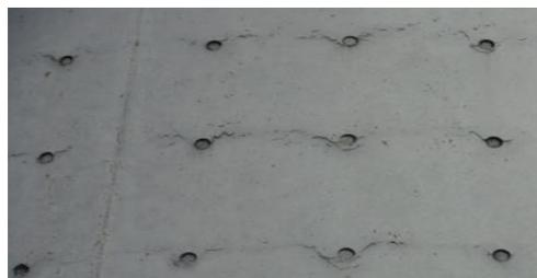
写真 5.2-6 型枠セパレーターコーン周辺に発生した沈下ひび割れ現象
