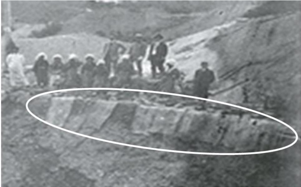
写真 4.2-4 基礎コンクリート養生用ムシロ
