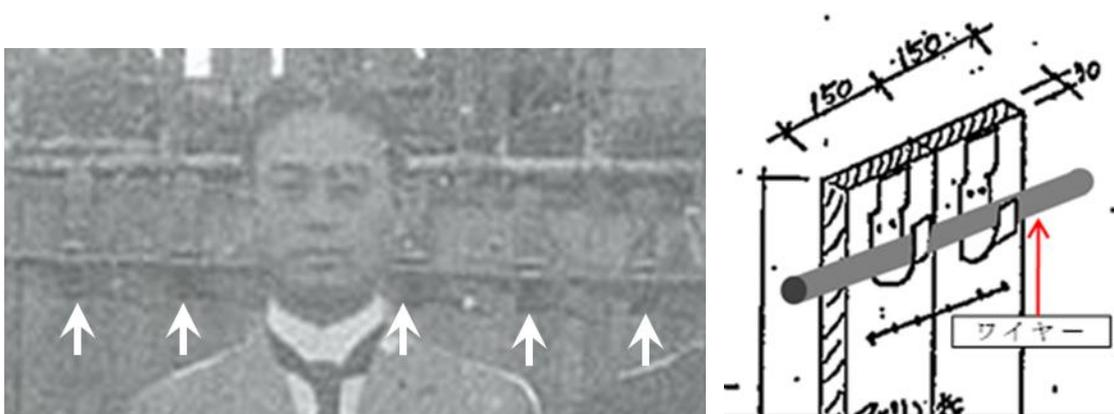
写真 6.2-1 型枠締付ワイヤー取付金物(矢印)と模式図
