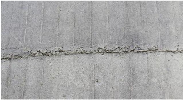
写真 5.2-9 打継目の型枠隙間から
