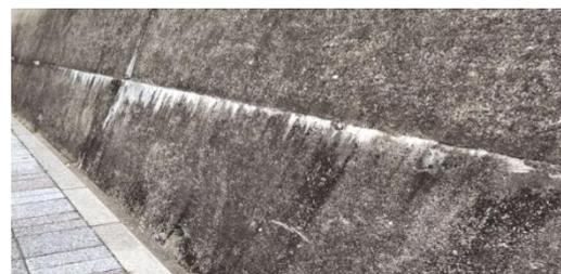
写真 5.2-2 道路構造物などの打継目の白華現象
