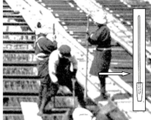
写真 2.2-10 白枠内右端部の拡大写真と搗固蛸
