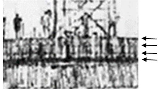
写真 5.1-10 原町無線塔の4段の型枠締付ワイヤー
