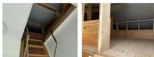
Photo. 1 木造応急仮設住宅の屋根裏収納
