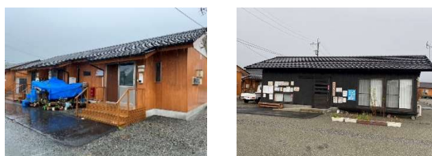
Photo. 2 瓦屋根に変更された木造仮設(左)とみんなの家(右)
