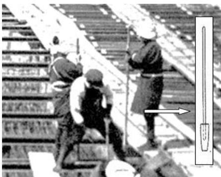
写真-9 利根川萬世水門工事基礎コンクリート施工状況(土木学会土木貴重写真コレクションより)
