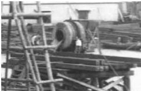
写真-7 円筒型(ドラム型)ミキサー(新潟萬代橋
