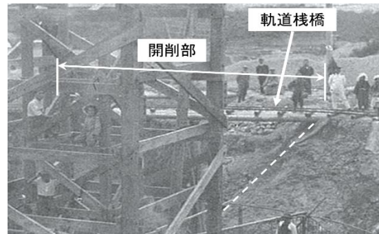
写真-4(古写真-2 の一部を拡大) 開削部と軌道栈橋
