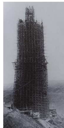
写真-8 旧日立鉱山精錬所煙突の足場(参考文献9)より
