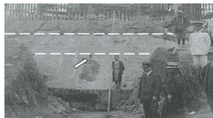
写真-7(古写真-3の一部を拡大) 基礎コンクリート(水抜穴の矢印とリフト割の点線)
