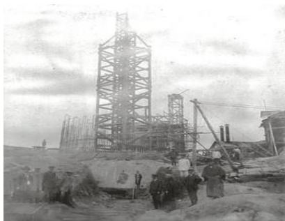
写真-6(古写真-3) 基礎コンクリート完成写真 (参考文献 2) より
