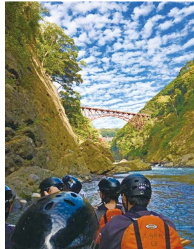
写真-8 第一白川橋梁 (立野峡谷) (熊本県)
