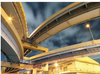
写真-1 福岡都市高速天神北ランプ(福岡県)
