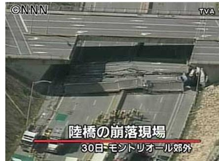
図-1.1.2 高速道路の跨道橋の崩落
