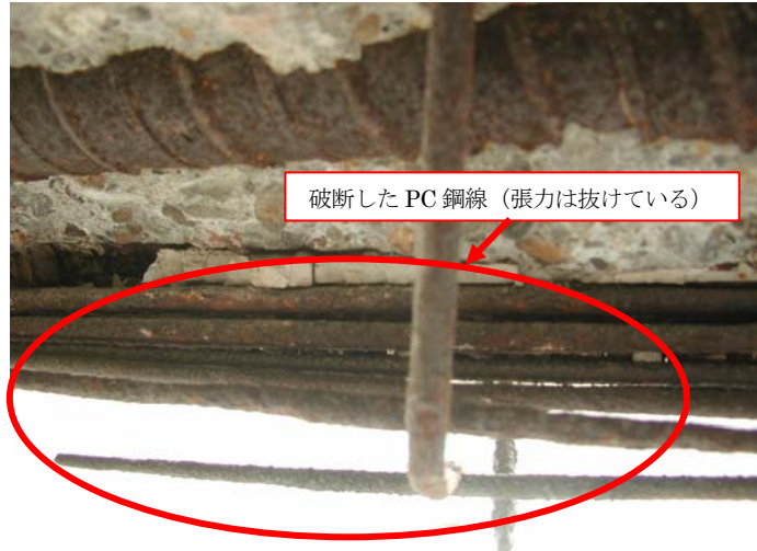
写真－4. 6. 1 塩害により PC 鋼材が破断した PC 構造物 [1]
