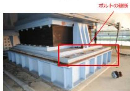
(b) 取付ボルト破断
