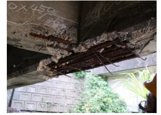
Fig.12 主桁の剥離
