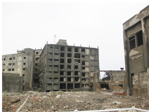
写真2 日本最古の鉄筋コンクリート造り高層住宅
