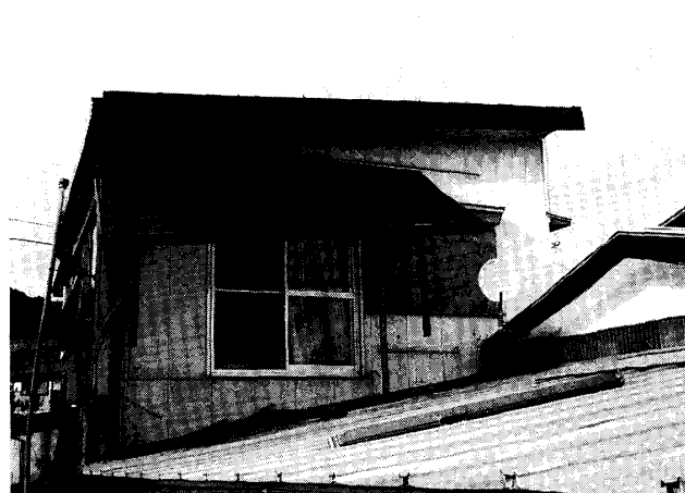
写真5 2階に取り付けられたテラスの被害。テラスの柱、床が無くなっている。
