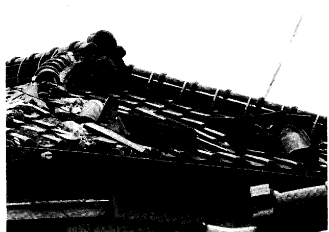
写真4 竜巻により壊された2階家屋の屋根瓦。強風により瓦が損壊したり、めくれ上がっている。なお、屋根瓦の被害は北側屋根の瓦に多く見られた。
