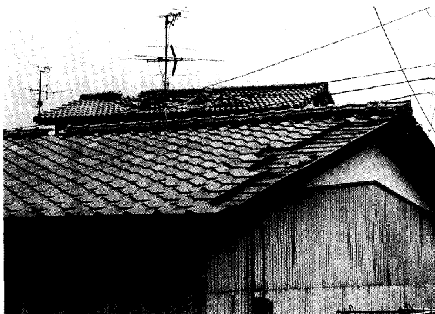
写真3 屋根瓦の被害。手前の平屋では右側の瓦が飛ばされた。後方2階家屋は、屋根中央部の被害が大きい。
