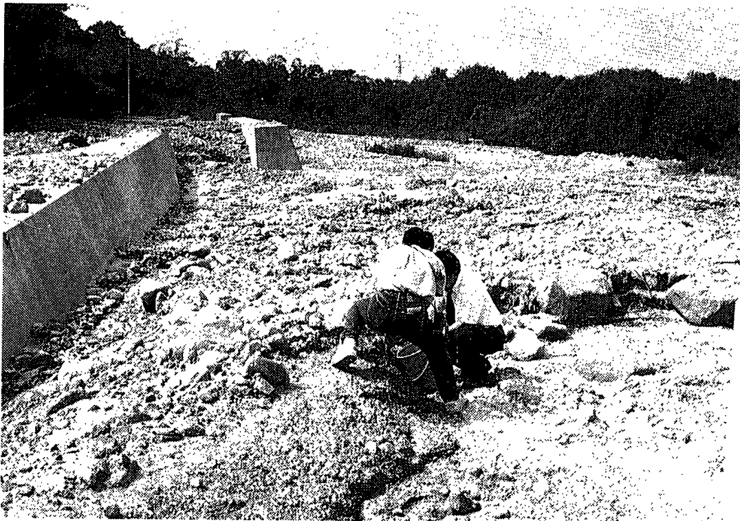
写真一3 1993年7月17日発生土石流の状況 (同年7月21日撮影、撮影者：後藤恵之輔)
