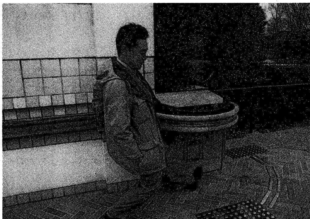
写真3 触知案内板に設けられた蹴り込み（ふれあいの庭にて）
