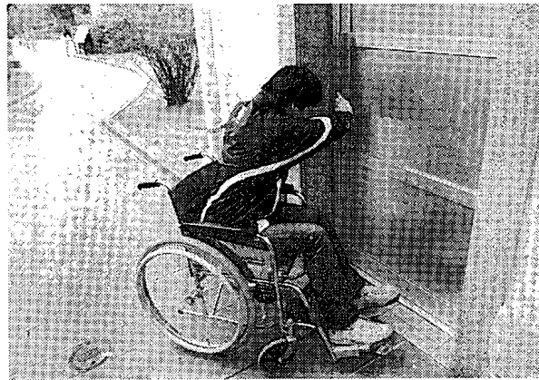
写真12 車いす使用者も開けにくい車いす用トイレの引き戸（平和公園）
