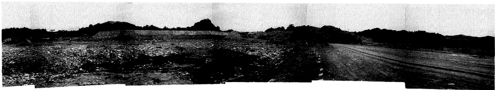
写真 2 一(g) 1998年 8 月31日撮影。陸続きになった部分は道路となったが、その下方は全部ゴミで埋め尽くされた。埋立ての高さが撮影地点とほぼ同じだ。
