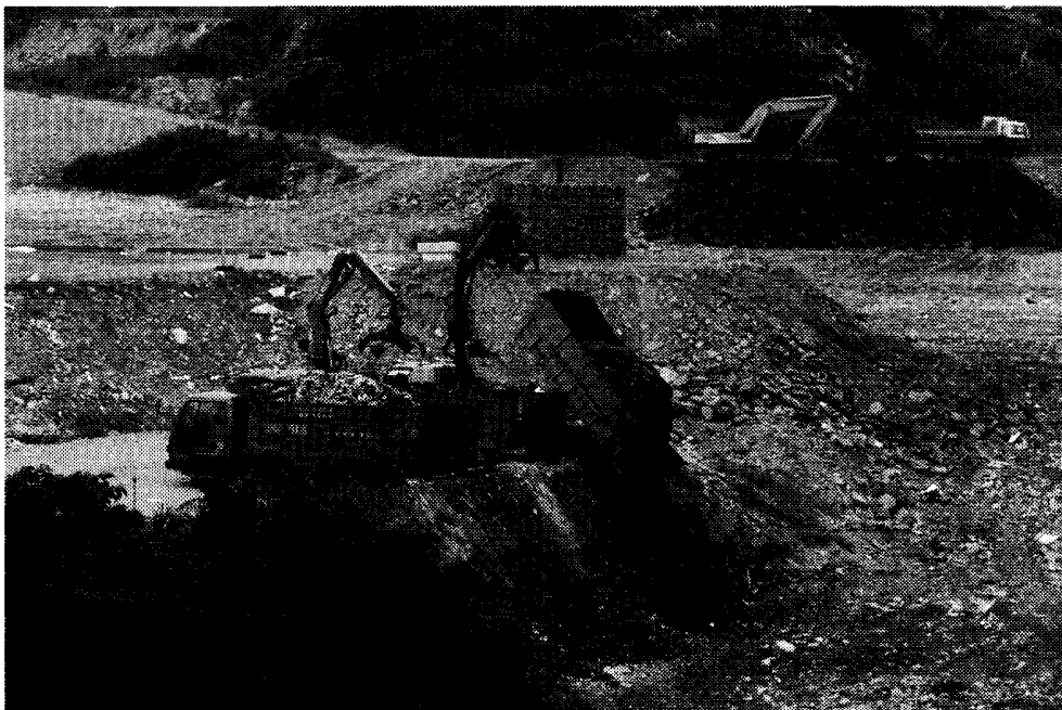
写真5 1997年8月22日撮影。持ち込みゴミ（事業系一般廃棄物）の投入状況
