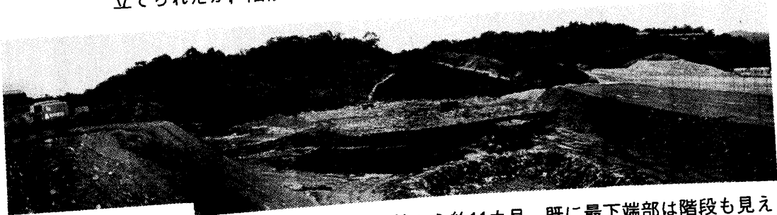
写真2-(b) 1994年1月9日撮影。埋立て開始後3カ月。僅か3カ月でどれだけの量が埋立てられたか、階段の高さで判断できよう。
