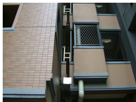
写真 3.4 エキスパンションジョイントの被害
