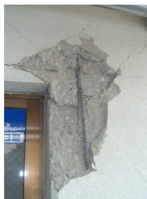
写真 3.13 非構造壁のコンクリート剥落
