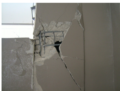
写真 3.9 雑壁のせん断破壊
