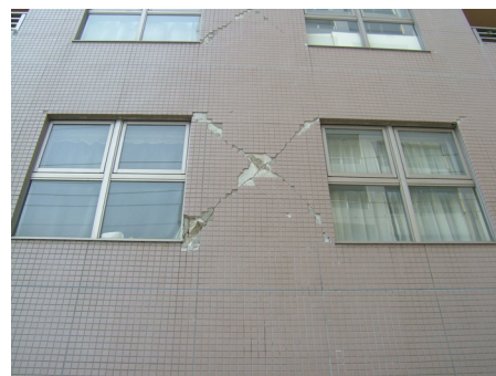
写真 3.3 外壁のせん断ひび割れ
