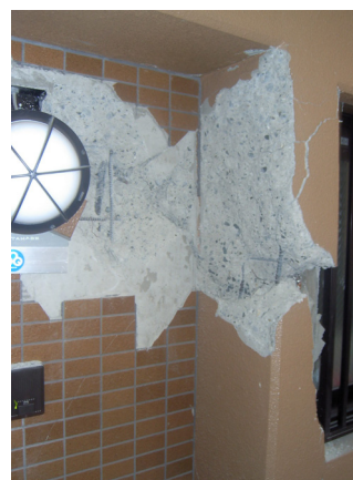
図 3.5 外壁の剥落
