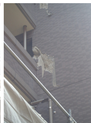
写真 3.12 破壊箇所の拡大
