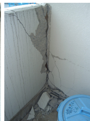
写真 3.14 ベランダ接合部の破壊
