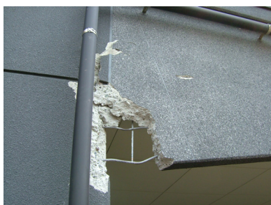
写真 3.6 非構造体の被害
