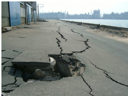
写真 3.15 博多港埠頭アスファルトのひび割れ
