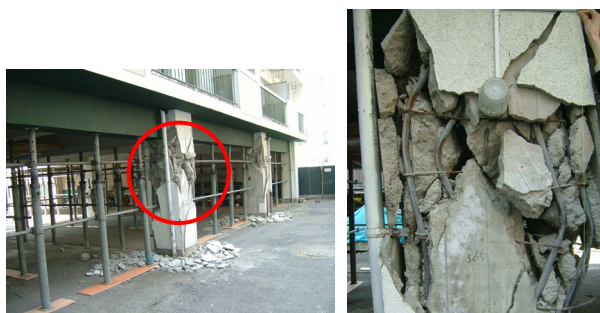
写真 3.1 1 階ピロティ柱のせん断破壊 写真 3.2 せん断破壊部分の拡大
