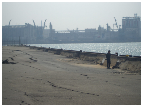
写真 3.16 博多港埠頭での液状化による地盤の沈下
