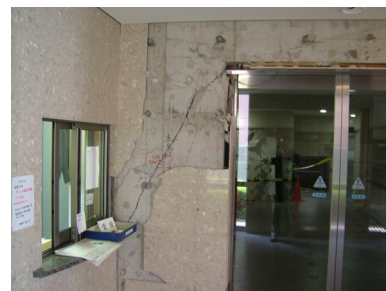
写真 3.10 1階ホール壁の剥落
