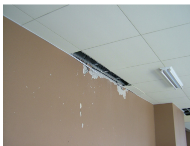
写真 3.7 天井の剥落
