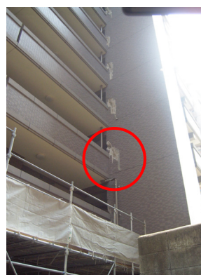
写真 3.11 接合部の応力集中によるコンクリートの剥離
