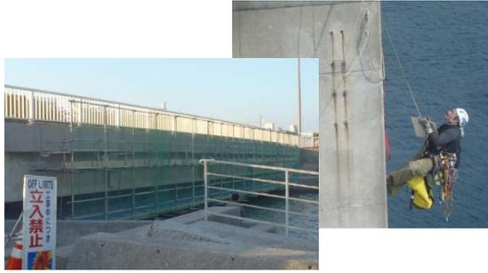
Fig. 1 吊足場とロープアクセスによる橋脚の点検
