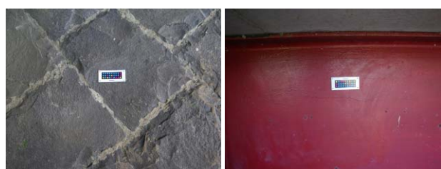
図7 コードの貼り付け（左：川西籠橋、右：大淀橋）
