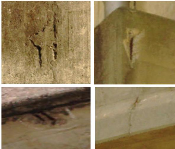
Fig. 9 3Dモデルによる外観劣化の様子
