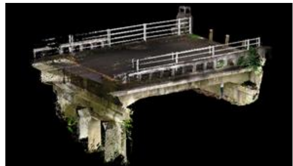
Fig. 4 橋梁 B の点群モデル
