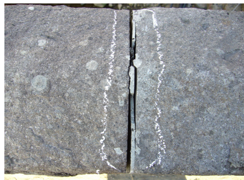
Photo. 3 左岸側高覧損傷状況
