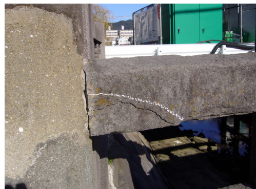
Photo. 4 左岸側高覧損傷状況
