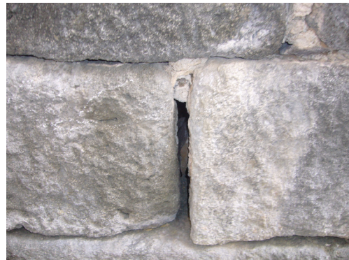
Photo. 2 右岸側目地部損傷状況
