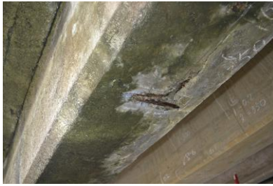
Photo. 2 A 橋（剥離・鉄筋露出）
