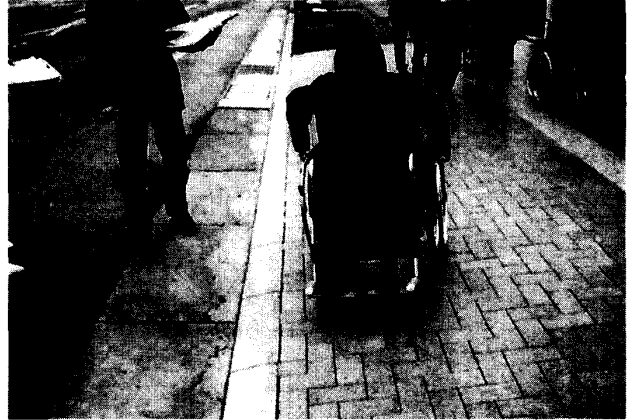
写真-6 車道側へ傾斜のある歩道
