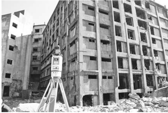
写真一 3D レーザースキャナ計測
