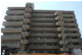
写真 2-1 対象構造物②全景
