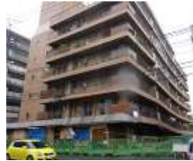
写真 1-1 対象構造物①全景
