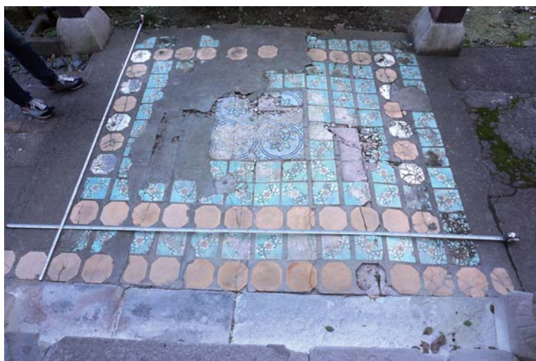
図9 玄関ポーチのタイル。北側の玄関扉付近より撮影した。
