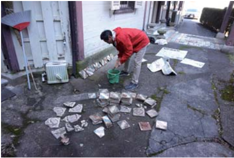
図3 保管タイルの洗浄作業
