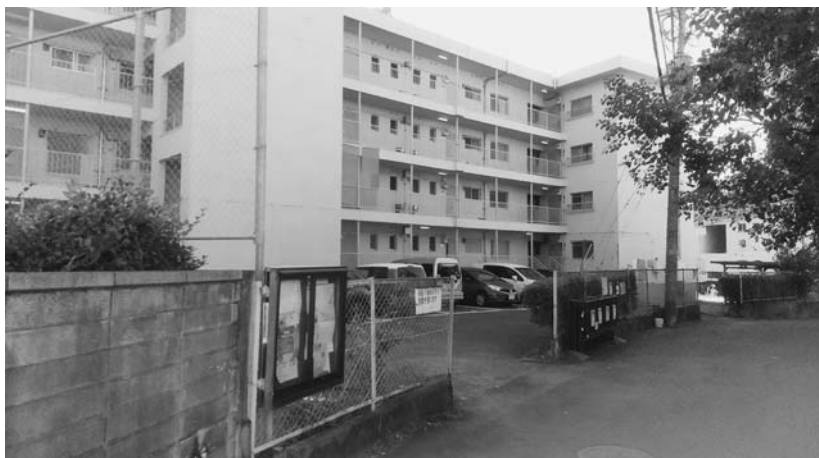
図10 中川宿舎2棟B棟西側（傭外国人官舎3号棟・4号棟・5号棟の跡地）
