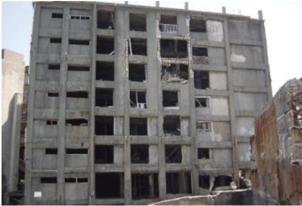
図 5. 30 号棟アパート
