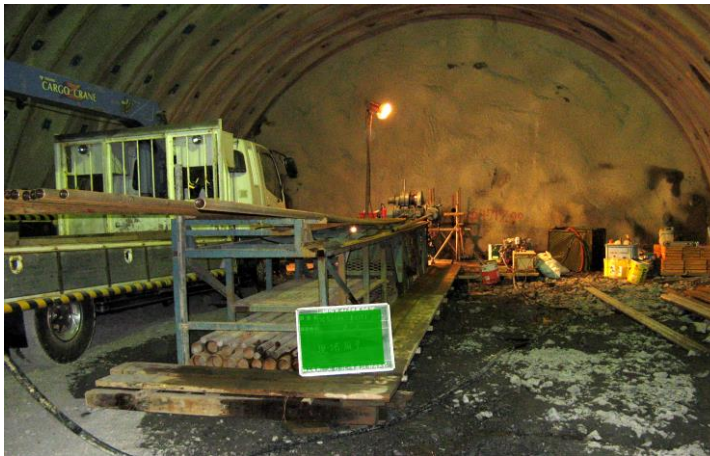
写真 3.3.1 水平コアボーリング実施例
