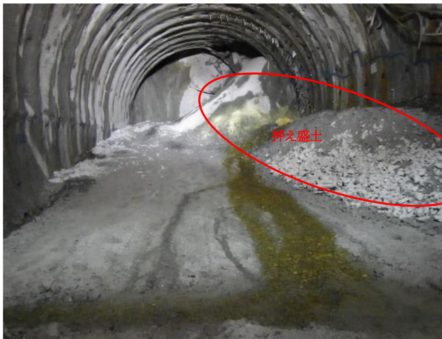
写真 4. 3. 3 崩落変状箇所の押さえ盛土状況写真
