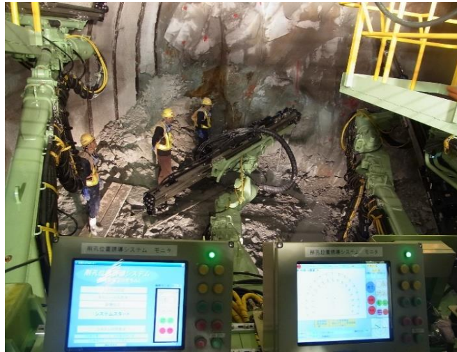
写真 3. 4. 1 前方探査の状況
