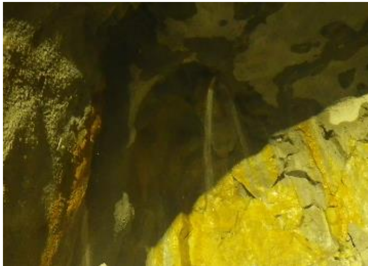
写真 4.3.6 TD916m 湧水状況
