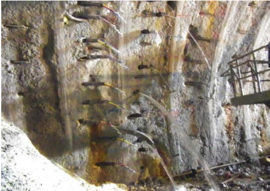
写真 4.3.4 水抜き工および地山補強工写真
