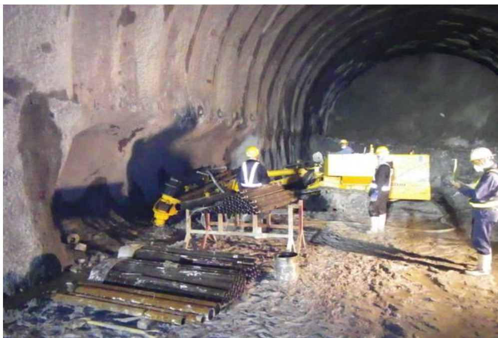
写真 4.3.8 No.3 長尺ボーリング実施状況
