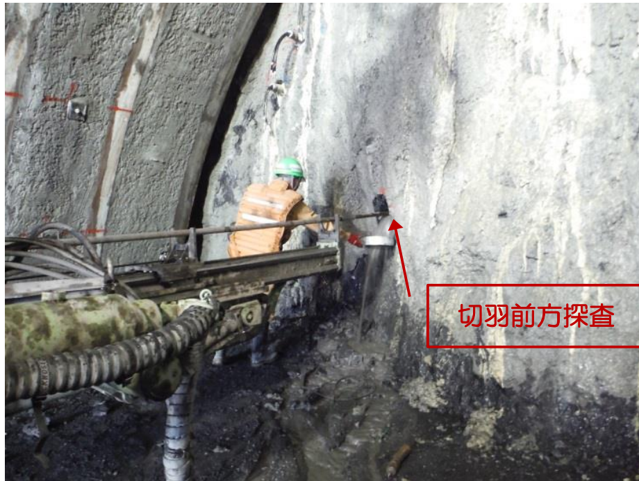
写真 3. 5. 1 切羽前方探査実施状況
