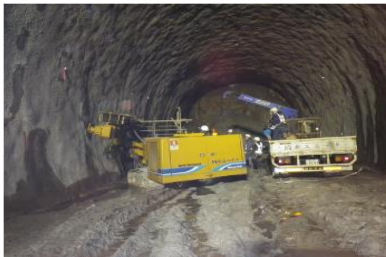
写真 4.3.7 TD900m 水抜き状況
