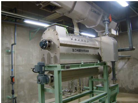
写真 3 破砕分別装置
