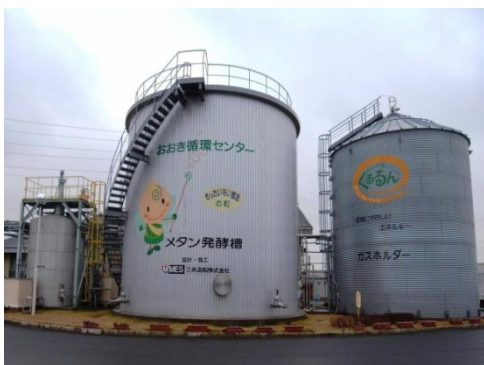
写真 4 メタン発酵槽
